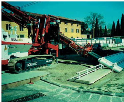
Skråboring og fjernelse af jord under tårnets fundamentet.
